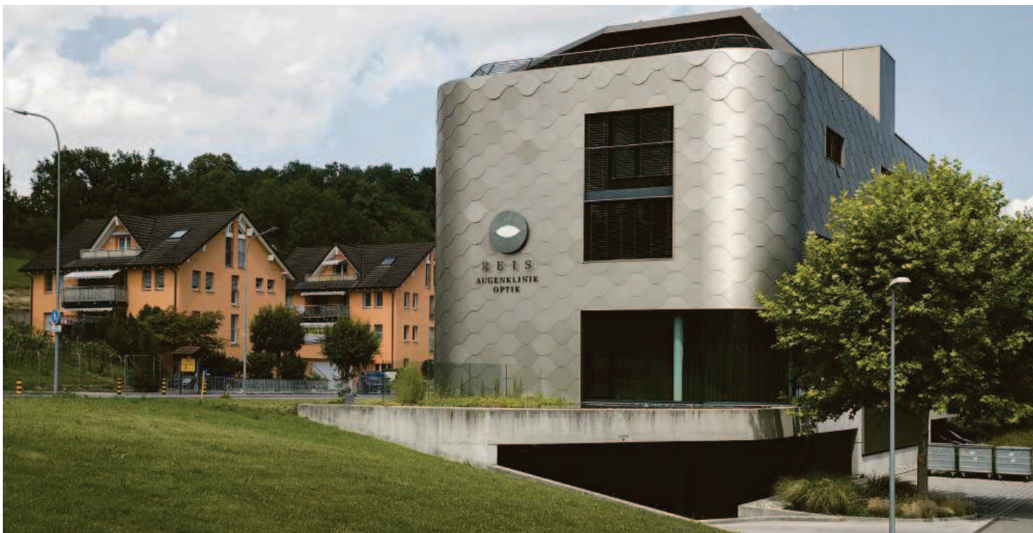
Im Jahr 2010 wurde die Augenklinik Reis in Gamprin gebaut.
