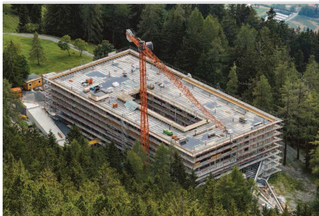
Noch wird fleissig gebaut. Bereits im Herbst werden aber die Wartelisten für Patienten der Privatklinik für Stressfolgeerkrankungen geöffnet. Bild: Daniel Schwendener
