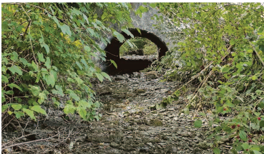
Der Oberaubach in Balzers bevor die Massnahmen eingeleitet wurden.
