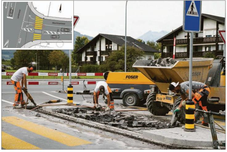
*Rückbau* Die Fussgängerinsel bei der Maschlinastrasse in Triesen wird rückgebaut (im kleinen Bild rot markiert) und um eine Fahrspur versetzt. Damit wird die Insel, wie normalerweise üblich, die beiden Fahrtrichtungen trennen. Was die Versetzung kostet und warum das Amt für Bau und Infrastrukur die erste Lösung überhaupt realisiert hat, ist unklar. Bild: Daniel Schwendener
