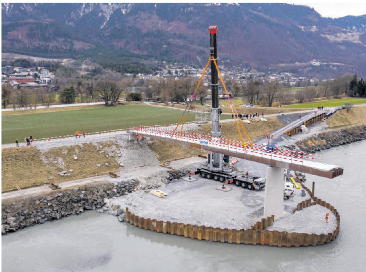
**Bauarbeiten** Gestern Vormittag wurde das erste vorgefertigte Stahlelement der Langsamverkehrsbrücke zwischen Vaduz und Buchs installiert. Ein 500 Tonnen schwerer Kran hat das Brückenteil in die richtige Position gehievt. Ende Juni 2019 soll sie offiziell eingeweiht werden. 3
