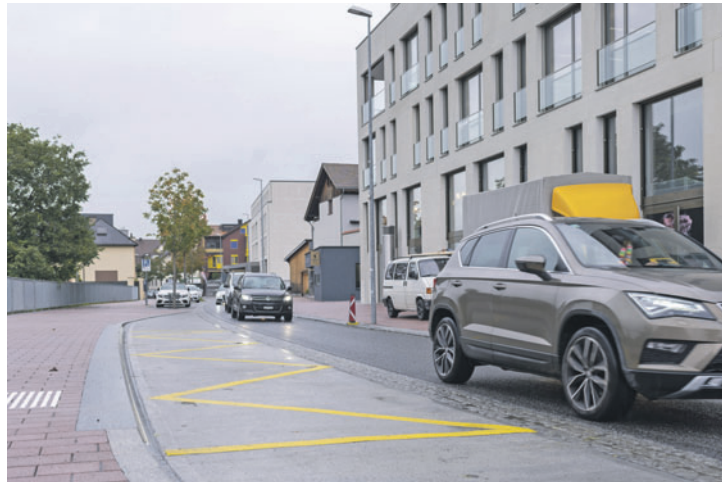
Die Busbucht bei der Haltestelle an der Poststrasse in Schaan. (Foto: MZ)
