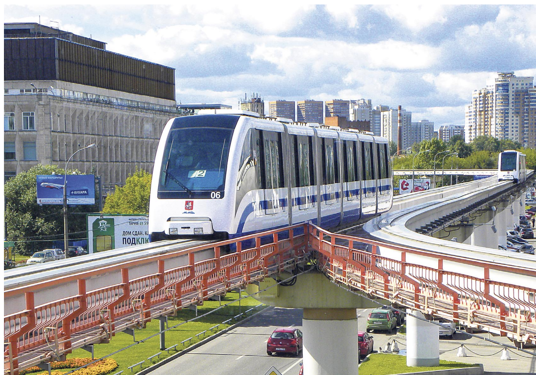
Fahren Fussballfans künftig mit so einer Bahn ins Rheinpark Stadion?
