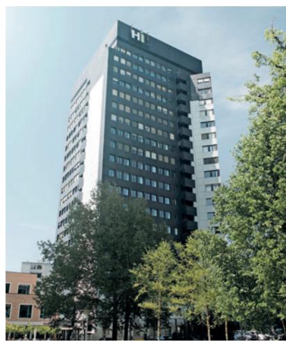
Grünes Licht für Bauarbeiten. (Foto: ZVG)
