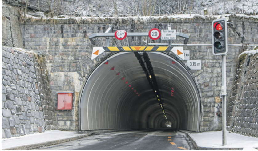
Der Stein des Anstosses: Die Sanierung des Tunnels Gnalp-Steg. (Fotos: MZ)
