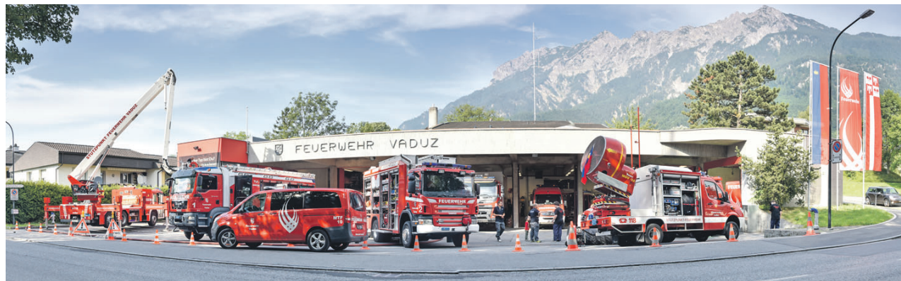
Das 40-jährige Gebäude der Feuerwehr Vaduz ist in die Jahre gekommen. (Foto: Nils Vollmar)
