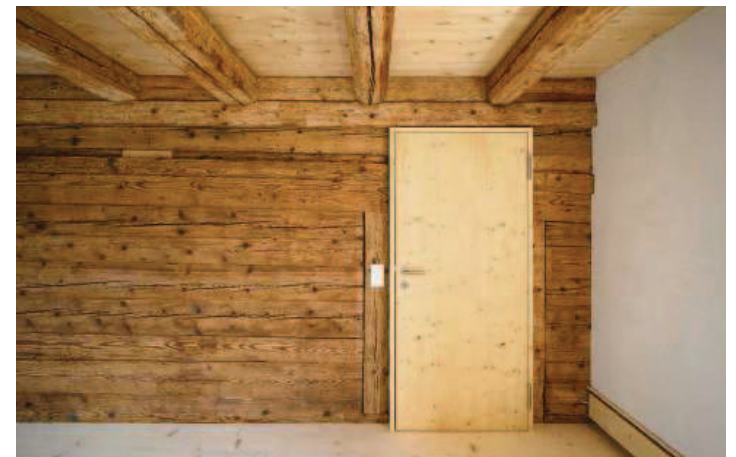
Die Deckennut und die Türbalken zeigen die alte Raumhöhe.
