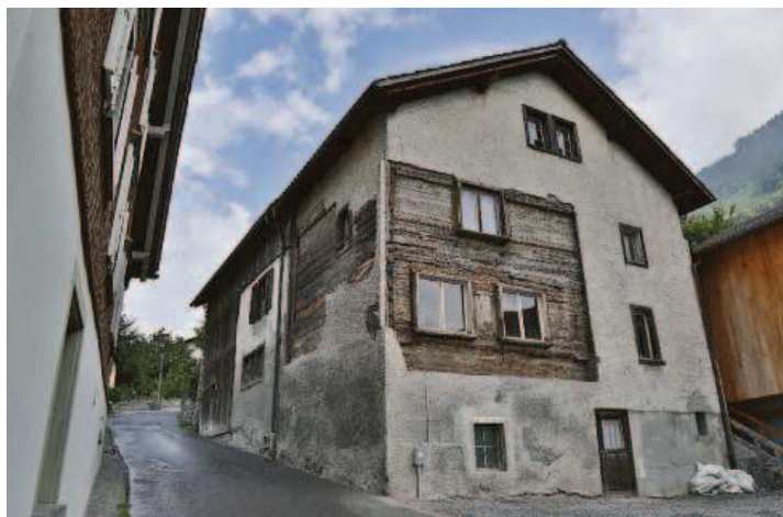
Freilegung der reich verzierten Holzfassade.
