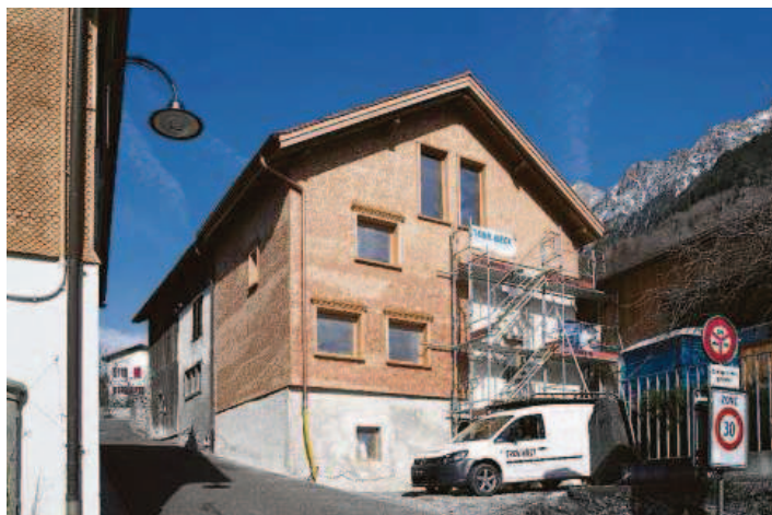
Das Gebäude während der Renovation.
