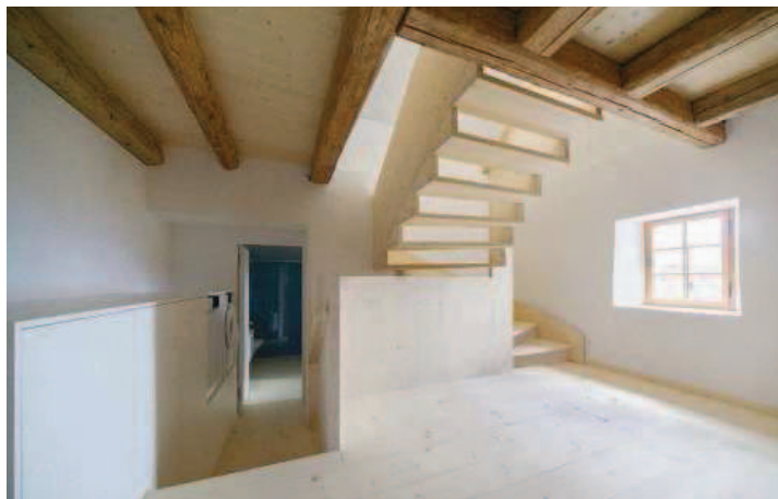
Mit dieser neuen Treppe wurde das Dachgeschoss erschlossen.
