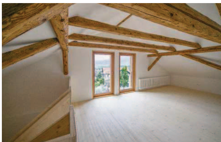
Die Dachkonstruktion wurde sichtbar gemacht.
