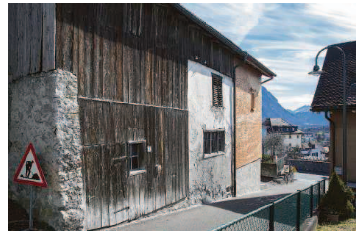
Der hintere Gebäudeteil befindet sich noch im alten Zustand.
